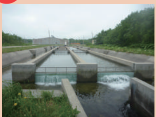
図6. サケマスふ化場の様子。フェンスのない施設が多い。
